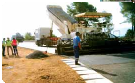
La pose du tapis d'enrobé a été effectuée en quatre jours pour respecter le planning d'une semaine de travaux.
