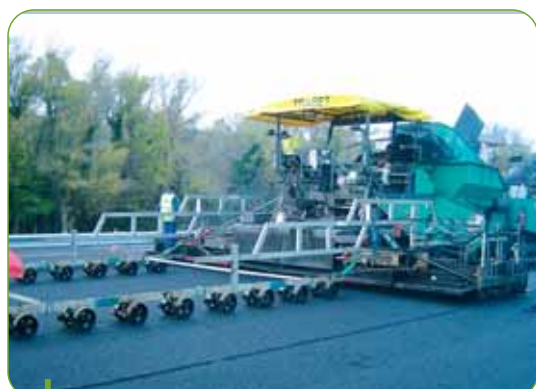
Le finisseur guidé à la poutre.
