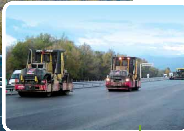
L'atelier de compactage à l'œuvre.
