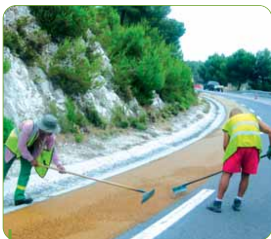
Pose de l'enrobé coloré pour une piste cyclable.
