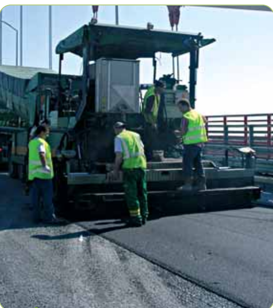
Pose de la couche de roulement sur l'étanchéité
