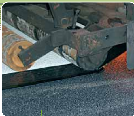
Pose de l'étanchéité par la DSM dérouleuse/soudeuse/maroufleuse
