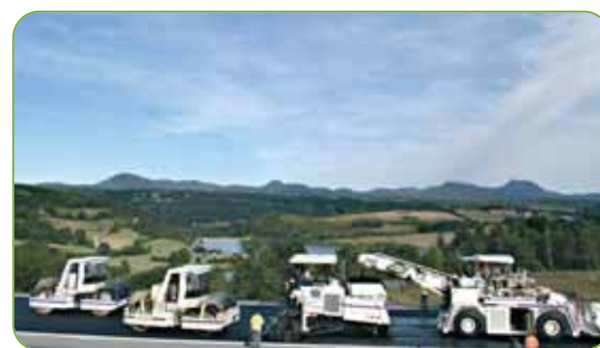
Atelier d'application avec un élévateur de cordon.
