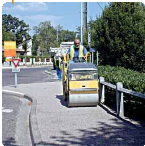
Compactage d'un revêtement de trottoir
