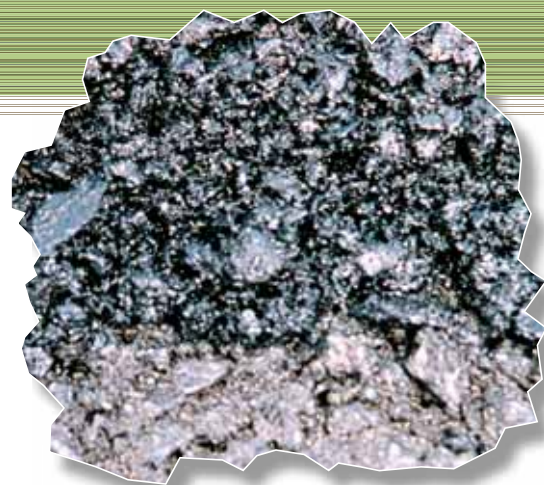
Première couche d'EME posée sur la GNT 0/31,5.
