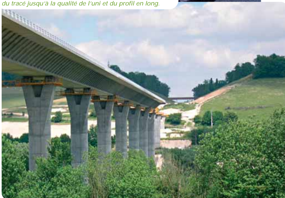
Un chantier particulièrement soigné, depuis la conception du tracé jusqu'à la qualité de l'uni et du profil en long.
