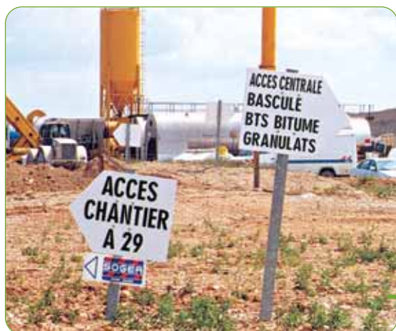
Le balisage de la circulation des camions témoigne d’un effort important pour assurer les meilleures conditions de sécurité.
