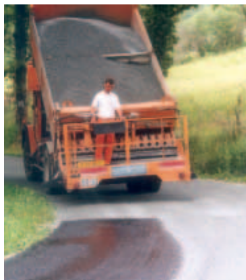
Gravillonnage en courbe sur l'émulsion fraîche.
