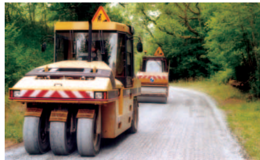
Compactage au moyen d'un compacteur à pneus et d'un cylindre lisse.
