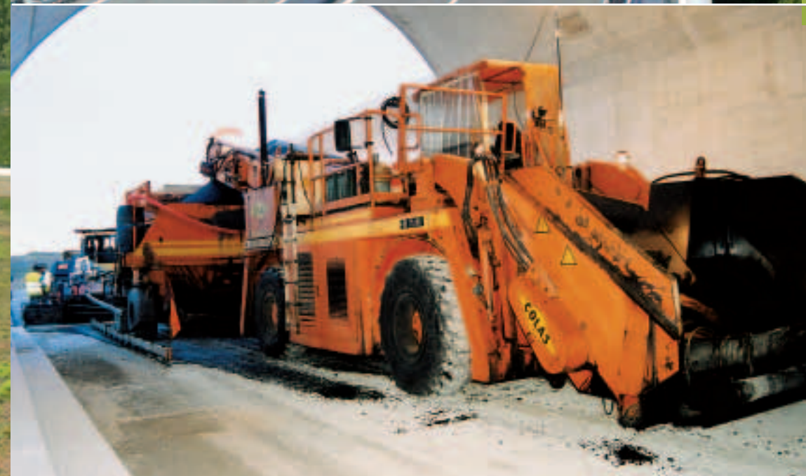
1. Des tranchées couvertes protègent deux sites paysagers particulièrement sensibles. 2. Finisseur en action dans une tranchée couverte.
