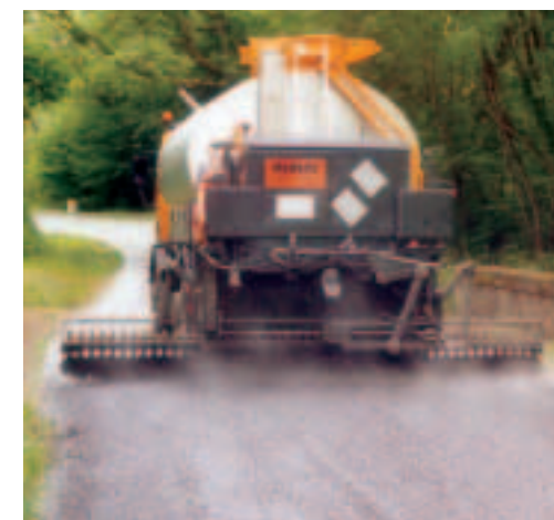
« Bouille » d'épandage de l'émulsion en action.
