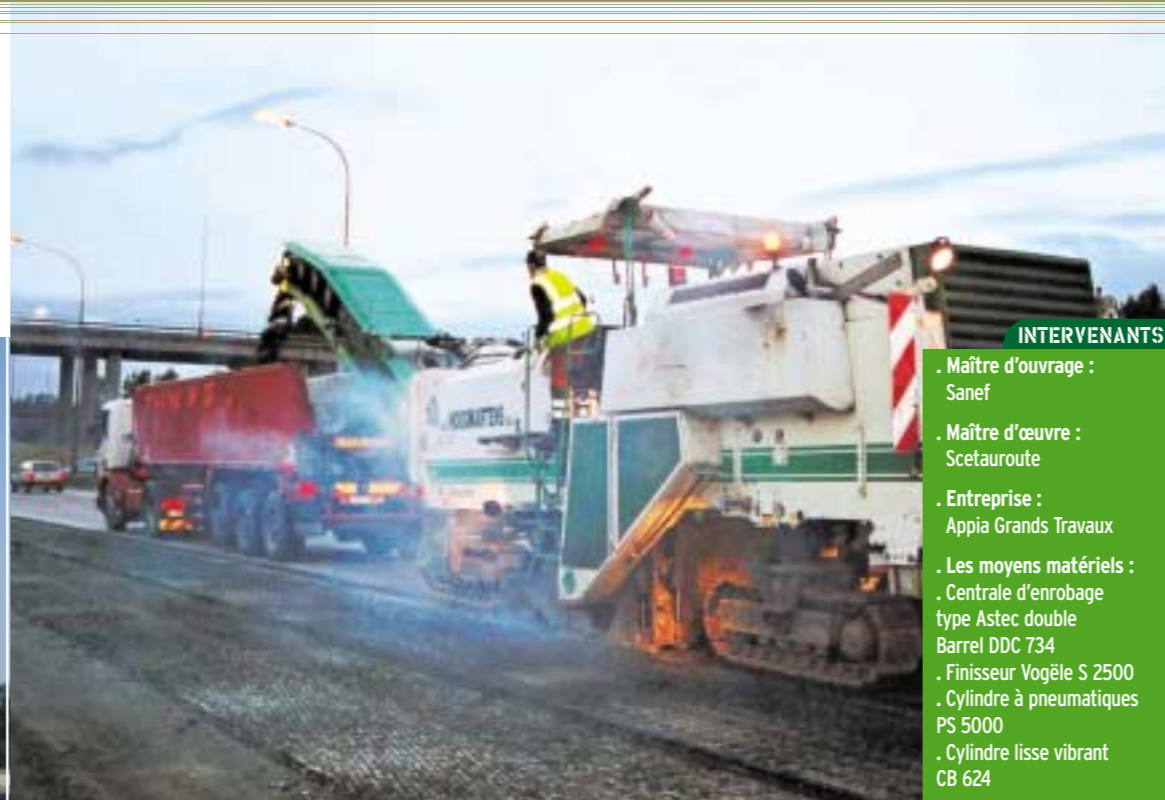
Opération de fraisage de la couche de roulement de l'A1.
