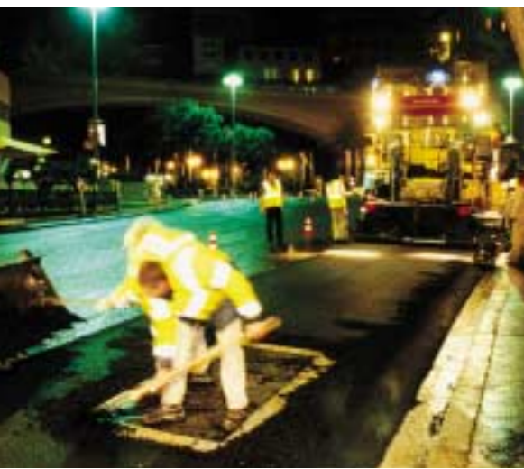
La piste se situe sur la voirie municipale de la principauté de Monaco. Les travaux de réfection se déroulent donc la nuit, afin de ne pas gêner les riverains.
