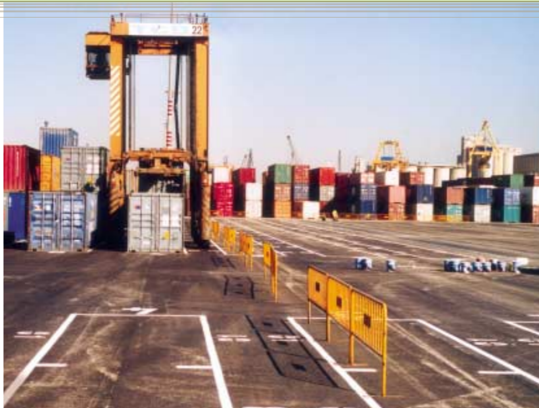
À gauche, un trastainer en activité, à droite, la zone de chantier.
