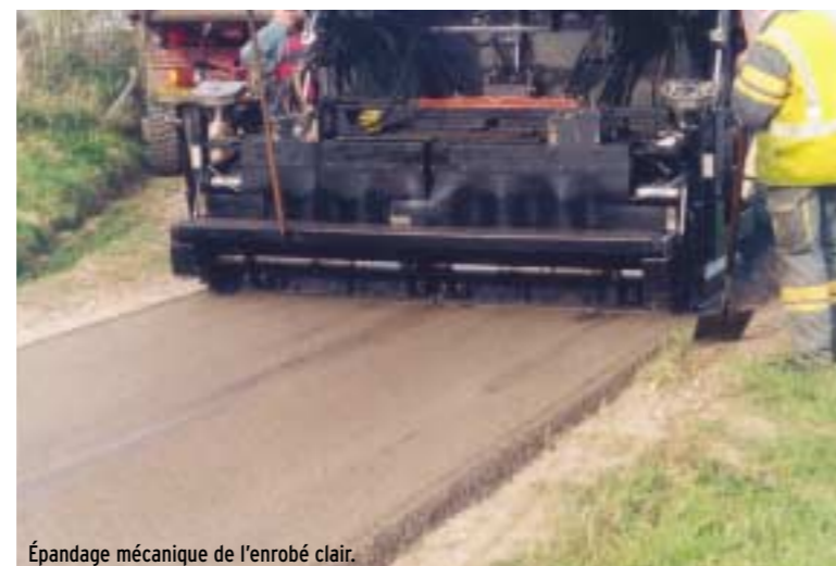
Épandage mécanique de l'enrobé clair.
