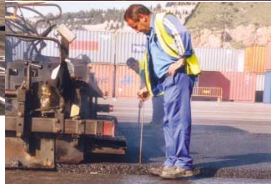
Des contrôles réguliers sont effectués pour vérifier l'épaisseur et la température des enrobés en place.
