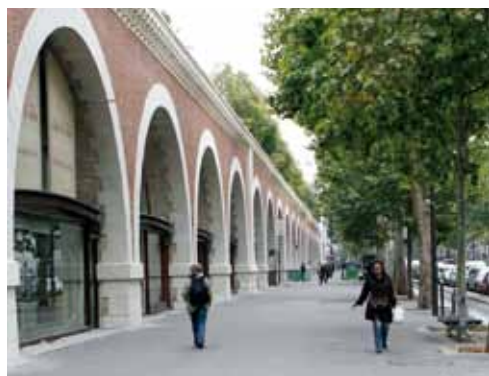
Trottoir parisien traité en asphalte coulé (avenue Daumesnil, 12 e )
