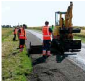
Mise en œuvre à la niveleuse de la grave-émulsion, puis compactage au cylindre et aux pneumatiques
