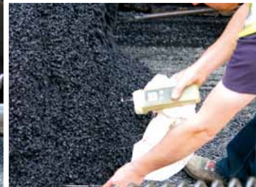
Grâce à l'emploi du bitume AZALT ECO 2 , les enrobés de la couche de roulement ont pu être mis en œuvre à 120 °C, 40 °C au-dessous de la température habituelle.
