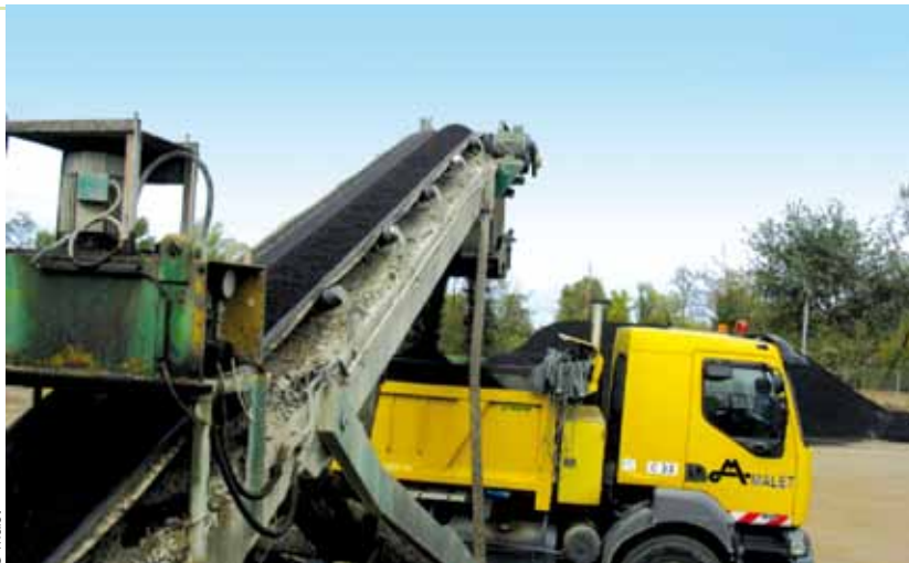
Chargement des agrégats d'enrobés retraités à l'émulsion
