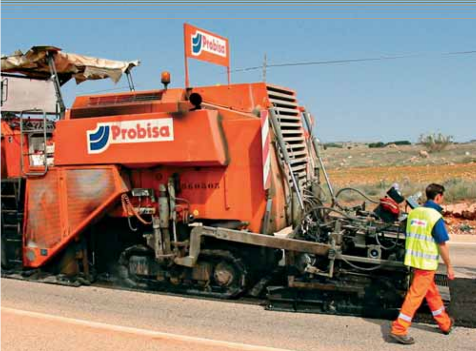
Une machine à recycler les enrobés à froid, sur place : la fraiseuse, en tête du train, est suivie d'un malaxeur, dans lequel les enrobés à recycler sont mélangés à de la mousse (ou de l'émulsion) et des additifs. La mise en place est effectuée classiquement par un finisseur.
