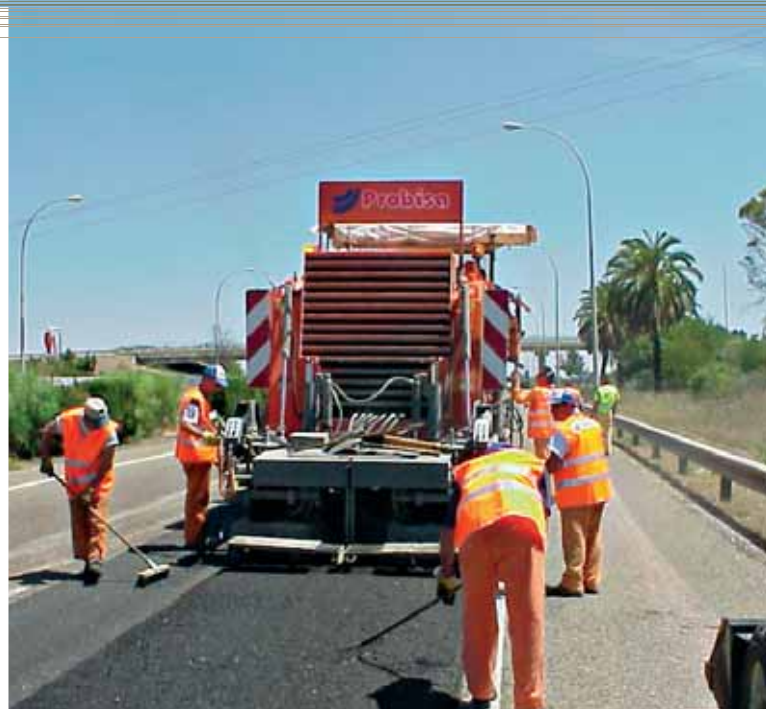
Une machine à recycler les enrobés à froid, sur place : la fraiseuse, en tête du train, est suivie d'un malaxeur, dans lequel les enrobés à recycler sont mélangés à de la mousse (ou de l'émulsion) et des additifs. La mise en place est effectuée classiquement par un finisseur.
