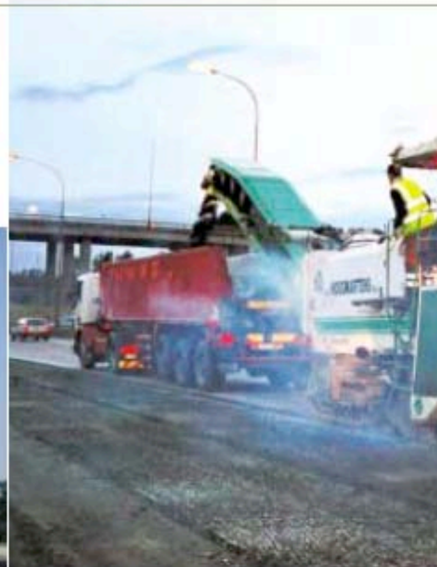
Opération de fraisage de la couche de roulement de l'A1.
