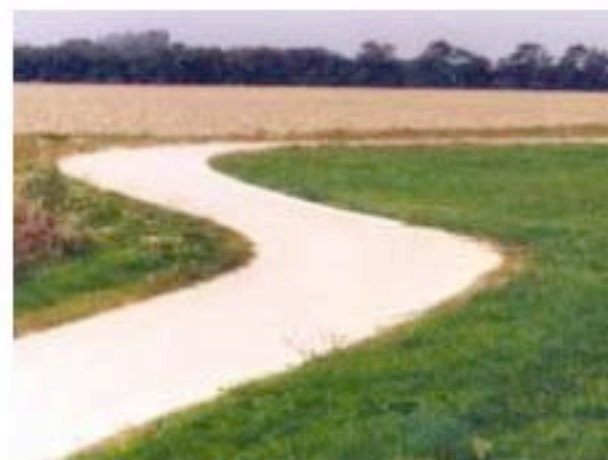
Le choix d'un enrobé clair, à base d'un liant incolore et de granulats d'origine locale, a permis la réalisation d'une piste qui s'inscrit harmonieusement dans le paysage.
