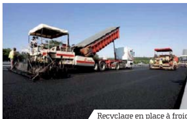
Recyclage en place à froid.
