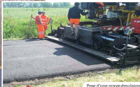
Pose d'une grave-émulsion.
