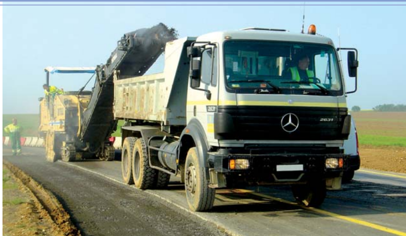
Fraisage des enrobés avant recyclage.
