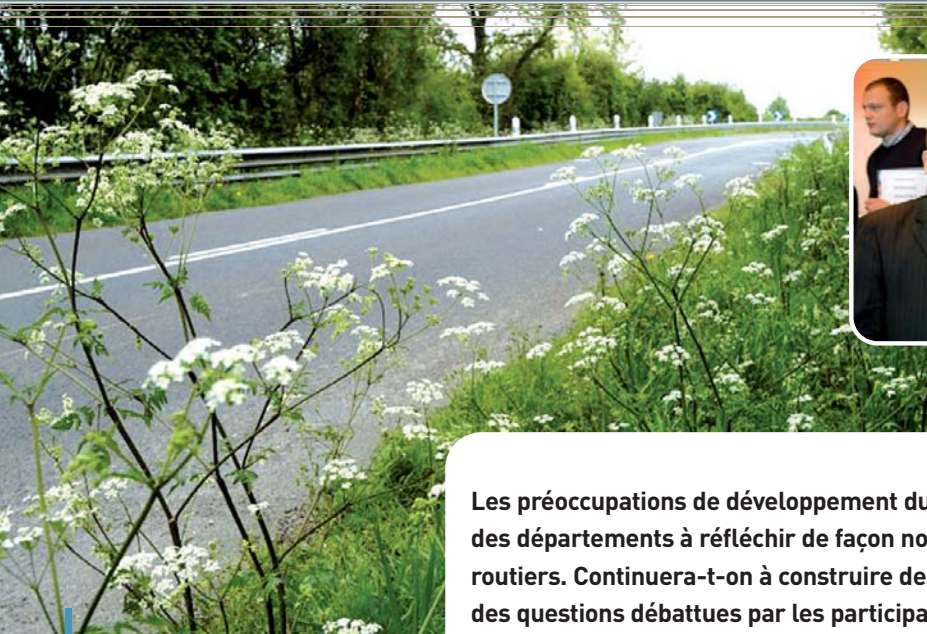
Le fauchage tardif améliore le filtrage des effluents et favorise la biodiversité dans les emprises vertes de la route.
