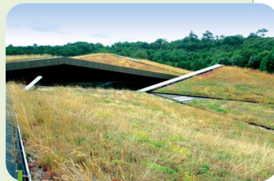
Historial de Vendée (85) : 6 000 m 2 de végétation mise en œuvre par rouleaux précultivés sur un complexe de culture de 12 à 15 cm d'épaisseur, spécialement adapté aux contraintes techniques du chantier : support bac acier et pentes allant de 8 à 70 %. Un système spécifique de retenue du substrat a été développé par SOPREMA pour ce chantier.
