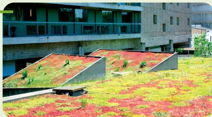
Cité Universitaire Maison du Brésil à Paris : 615 m 2 de végétation mise en œuvre par rouleaux précultivés sur un complexe de 10 cm d'épaisseur. Support béton sur pentes comprises entre 5 et 40 %.
